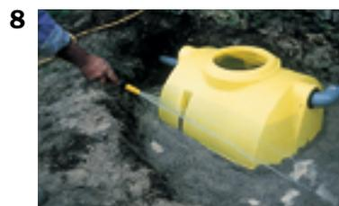
**6. Côté sortie du bac, réaliser les raccordements nécessaires avec du tuyau de 100 mm de diamètre.**
