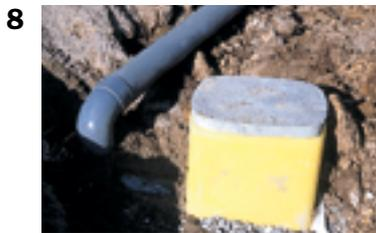
8. Entre la fosse septique et le regard de répartition, intercaler une canalisation d'aération avec du tube PVC de 100 mm de diamètre.
