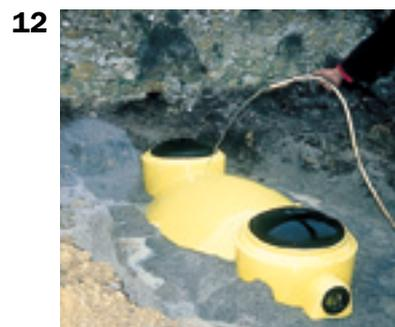
**13. Réaliser les raccordements d'arrivée : eaux vannes venant des W.C. et eaux ménagères venant du bac dégraisseur.**
