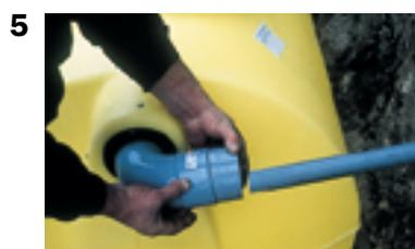
**5. Raccorder la canalisation de sorties des eaux ménagères de la maison au coude en intercalant un manchon de réduction adapté.**
