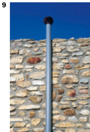
9. Au sommet de la canalisation de ventilation un aspirateur dynamique assure l'extraction des gaz produits dans la fosse septique.
