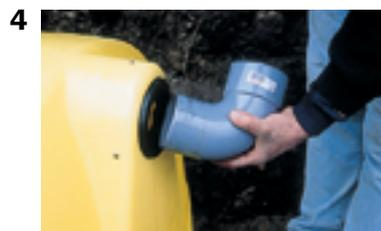
**4. Insérer dans le trou d'entrée un coude PVC (ou un manchon) de 100 mm de diamètre.**
