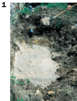
**1. Creuser un trou suffisamment grand pour recevoir le bac et d'une hauteur correspondant à sa hauteur plus 10 cm. Étaler une couche de sable de 10 cm dans le fond du trou.**
