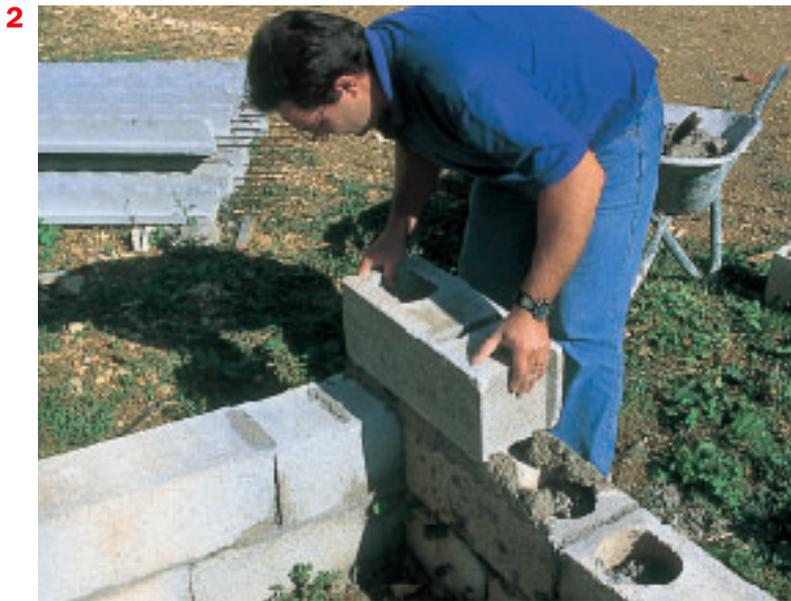
**2. Poser un parpaing sur le lit de mortier.**
