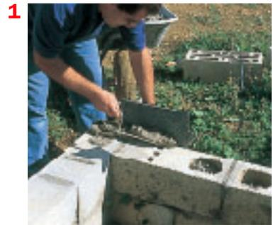
**1. Déposer du mortier sur les deux bords du rang précédent ou sur la semelle. La taloche permet de placer le mortier avec précision.**
