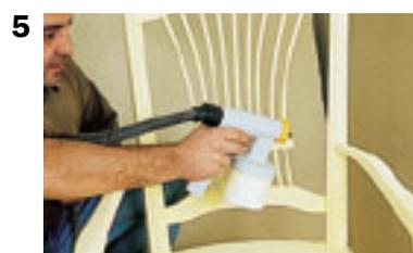
**1. Appliquer la sous-couche au pistolet sur toutes les surfaces du siège.**
