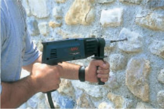
1. Mettre la perceuse ou le perforateur électropneumatique en position "percussion".
