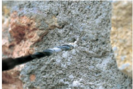
6. Tenir la machine fermement à deux mains, et appuyer bien droit avec une pression moyenne et constante.
