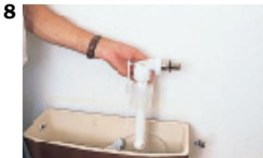
**8. Installer ensuite le mécanisme de remplissage.**
