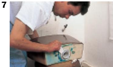
**7. Serrer bien à fond l'écrou plastique de blocage sous le réservoir.**
