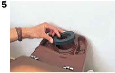
**5. Remplacer l'ancien joint de chasse par le neuf qui accompagne le nouveau mécanisme.**
