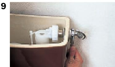
**9. Raccorder le mécanisme de remplissage au robinet extérieur.**
