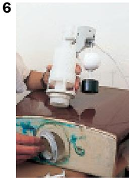
**6. Monter le mécanisme de cloche dans le réservoir sans oublier les joints d'étanchéité.**
