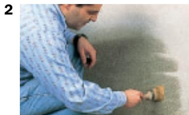
**2. Traiter le crépi trop poreux avec un hydrofuge de façade, applicable également sur une façade peinte.**
