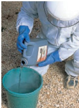
**1. Préparer la solution acide en versant 10 à 20 cl d'acide dans 1 l d'eau.**
