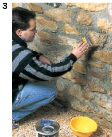
**3. Les murs en pierres offrent souvent des passages à l'eau de pluie au niveau des joints. Si les joints sont très dégarnis, il faut rejointoyer. De toute façon, une imperméabilisation est conseillée. Appliquer le produit en une seule couche,**
